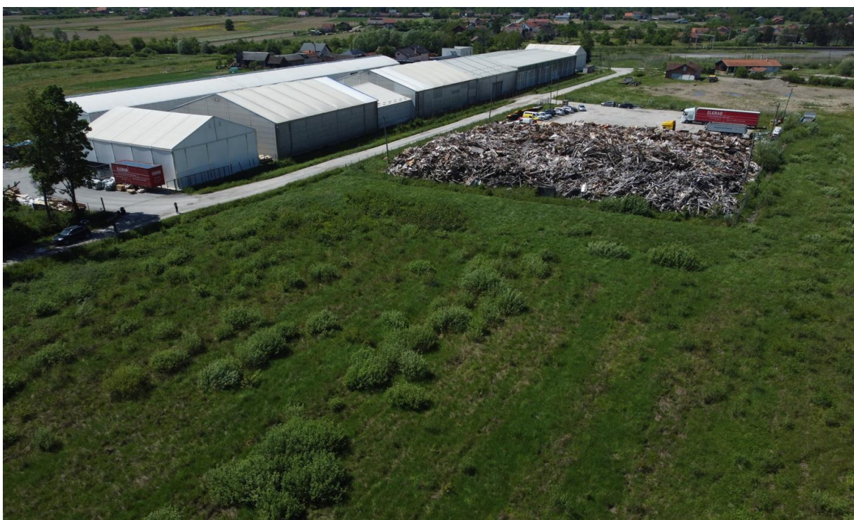
Fotografija C 1: Zračni pogled s istoka na zapadni dio lokacije zahvata Izvor: Terenski obilazak
